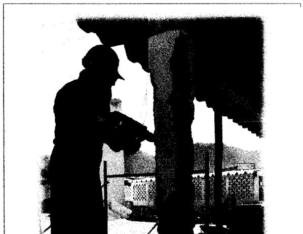
FOTO N° 12: PICADO DE RECUBRIMIENTO DE COLUMNAS
