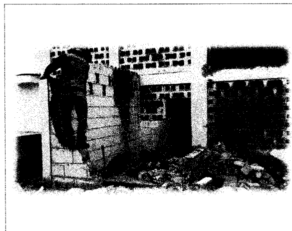
FOTO N° 06: INICIO DE DEMOLICIÓN EN MUROS.
